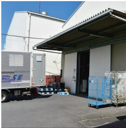
三郷センター 三郷第二倉庫 400坪 埼玉県三郷市彦沢1-124 EC物流センター業務及び什器、溶接材等の保管倉庫
